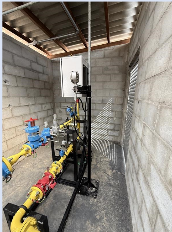
Foto 02 – Aspecto do suporte do eletrocorretor – vista lateral
