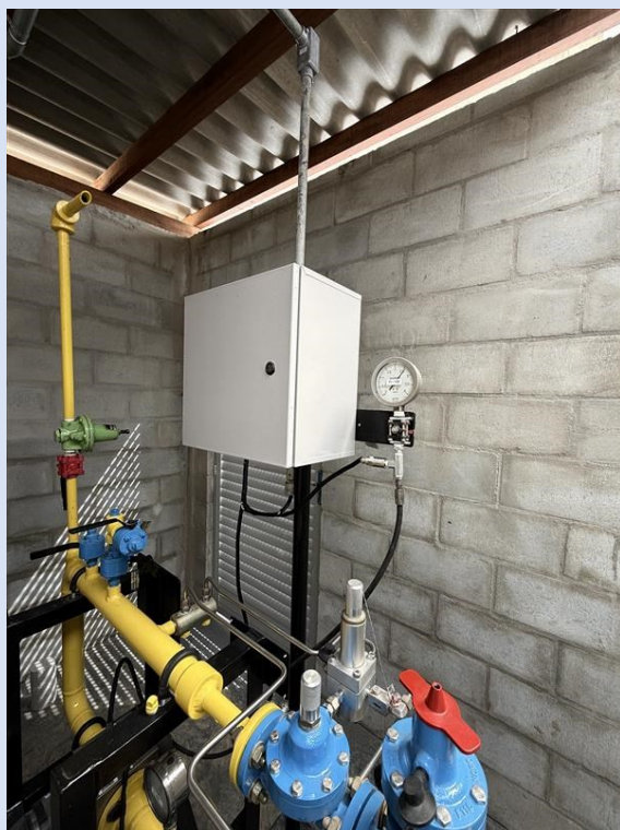
Foto 01 - Aspecto do suporte do eletrocorretor – vista frontal
